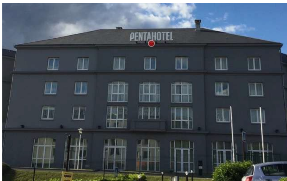
Exemples d'enseignes sur toiture ou terrasse en tenant lieu à Roissy-en-France
