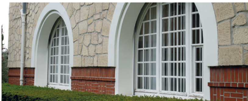
▲ Pas de temps à perdre pour économiser l'énergie. Dès cette année, la Ville va remplacer toutes les fenêtres de la mairie principale pour améliorer l'isolation du bâtiment.
